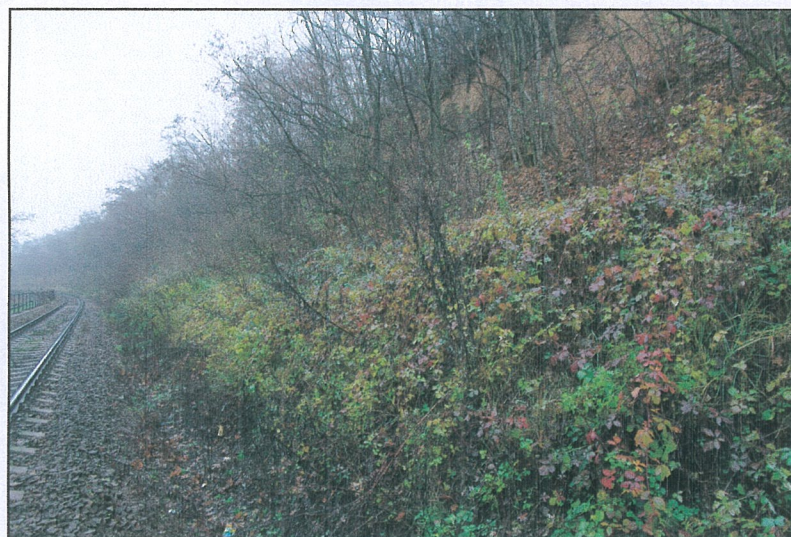
Obr. 3 Svah zarostlý stromovou vegetací v km 0,300. U horní hrany svahu je patrná kolmá stěna tvořená zvětralinami alterovaného granodioritu, pohled směr Jihlava
